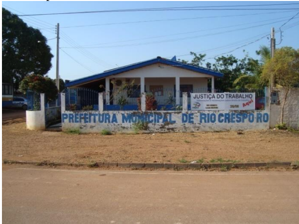
Foto 145: Vista da fachada da Prefeitura Municipal de Rio Crespo.
