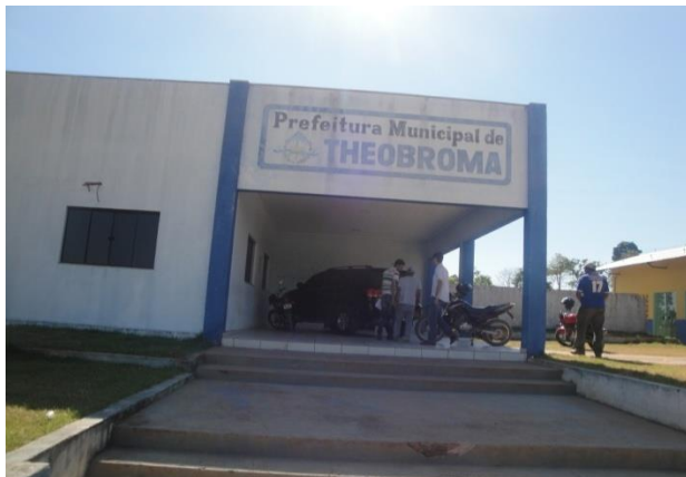
Foto 155: Vista da fachada da Prefeitura Municipal de Theobroma.
