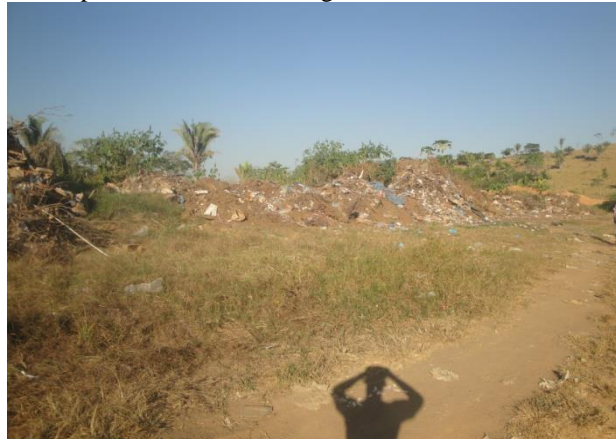
Foto 80: Vista das pilhas de entulhos no lixão ativo do Município de Governador Jorge Teixeira.
