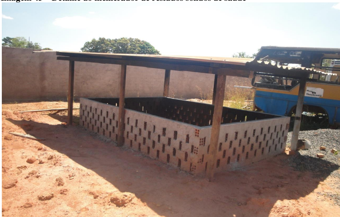
Imagem 45 – Detalhe do incinerador de resíduos sólidos de saúde
