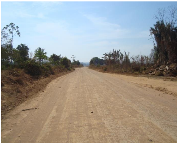
Foto 171: Vista do acesso ao lixão do Município de Vale do Anari.
