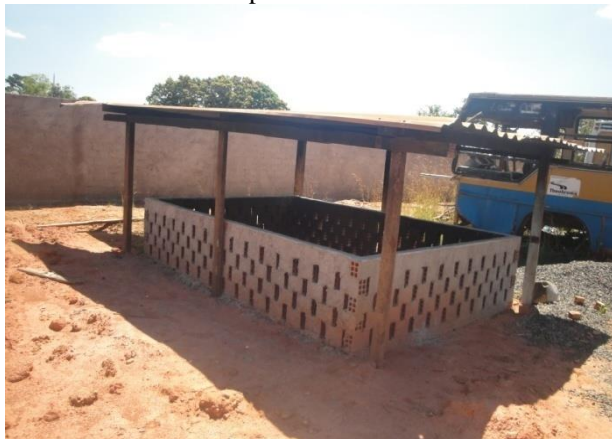
Foto 165: Vista do forno onde são incinerados os resíduos sólidos de natureza hospitalar.
