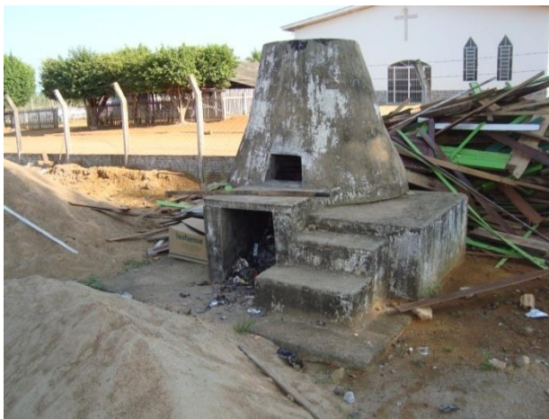
Foto 153: Vista do forno onde são incinerados os resíduos de natureza hospitalar.
