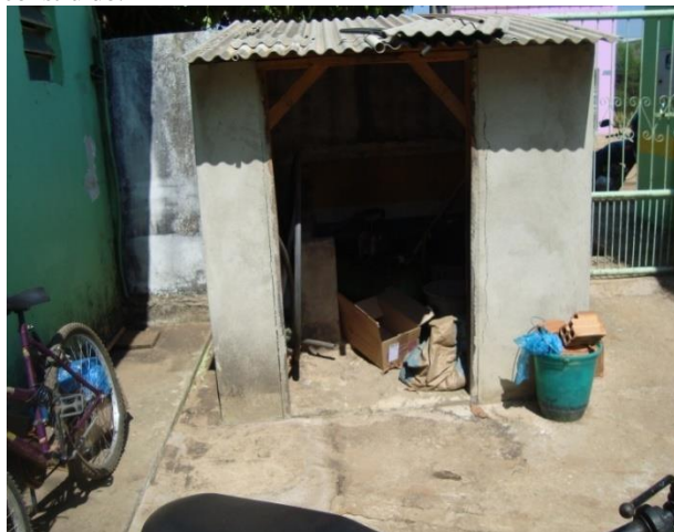
Fotografia 04: Depósito de resíduos de saúde recém construído.
