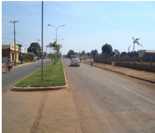
Foto 170: Vista do arruamento do Município de Vale do Anari.
