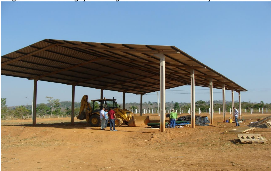
Imagem 12 – Detalhe do galpão de triagem do aterro sanitário de Ariquemes.
