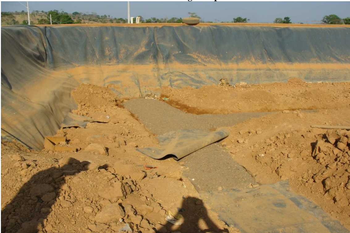
Imagem 16 – Detalhe do dreno de percolados na célula receptora no primeiro plano do talude da célula revestido com manta bidin no segundo plano
