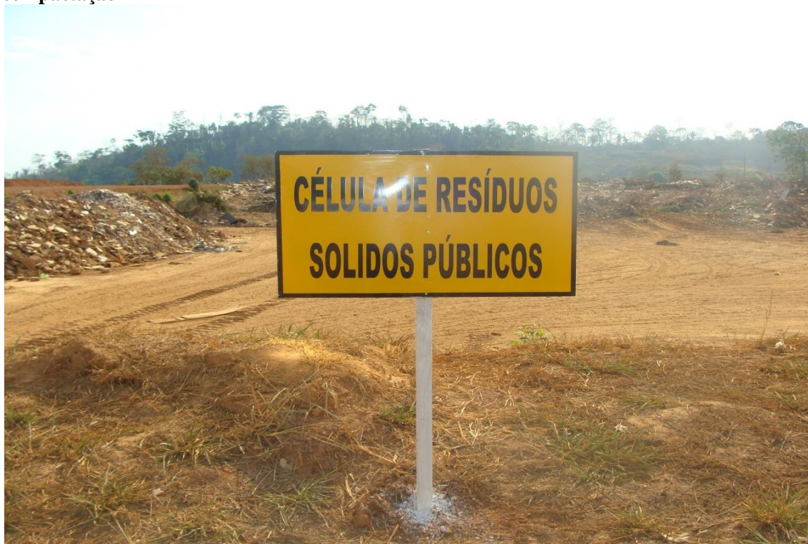
Imagem 14 – Vista do depósito de resíduos sólidos domiciliares na célula de recepção e compactação
