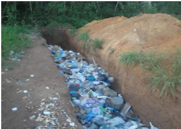
Foto 85: Detalhe das valas escavadas para aterrar os resíduos sólidos no lixão do Distrito de Colina Verde.
