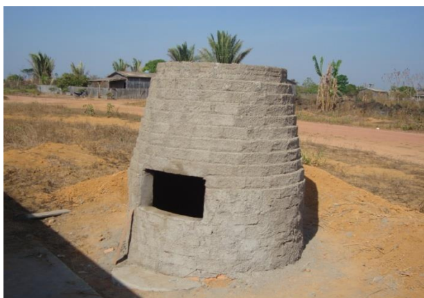
Foto 179: Vista do forno onde são incinerados os resíduos sólidos de saúde.
