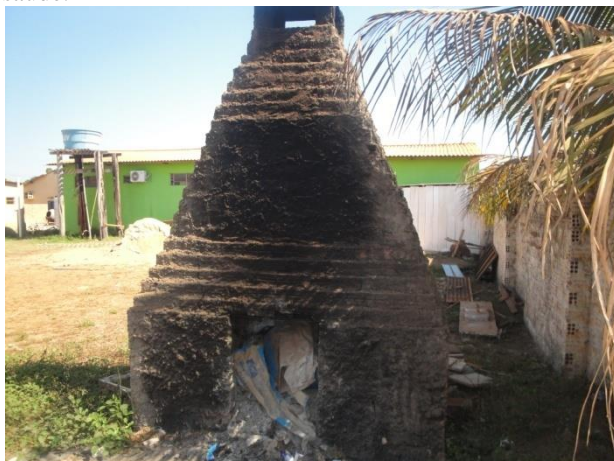
Foto 96: Detalhe do forno de incineração de resíduos de saúde.
