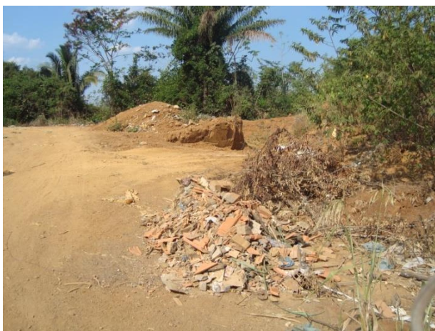
Foto 131: Detalhe de resíduos de construção civil.
