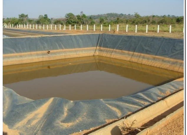
Foto 28: Lagoa Anaeróbica.
