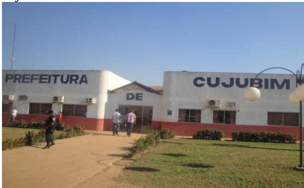
Foto 57: Vista da fachada da Prefeitura Municipal de Cujubim.
