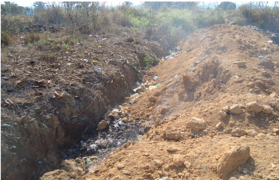
Imagem 51 – Detalhe de aterramento da massa de lixo queimada na vala
