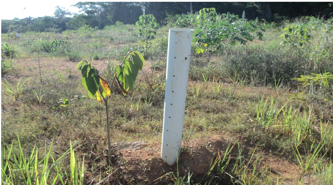
Imagem 21 – Dreno de gases ao lado de uma planta de Cupuaçu ( Theobroma grandiflorum ), em área de remediação ambiental do antigo lixão
