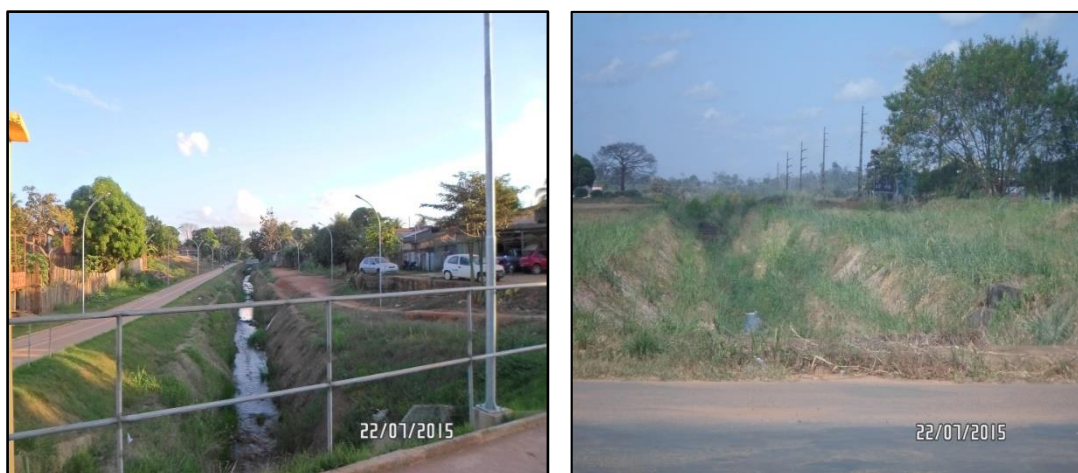
Figura 21. Vista de canal de macrodrenagem.
