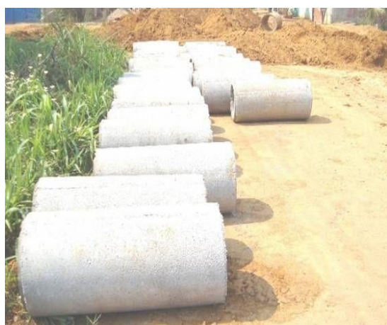
Manilhas de concreto
