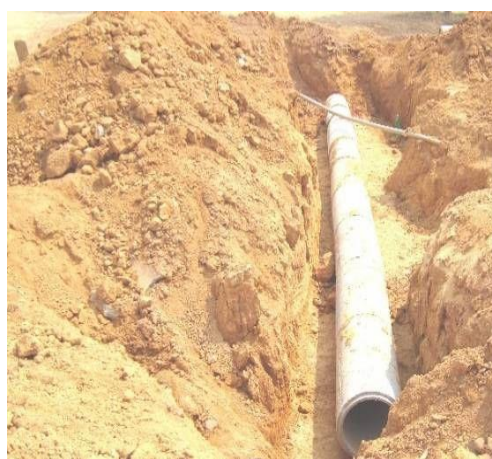
Instalação de galeria subterrânea
